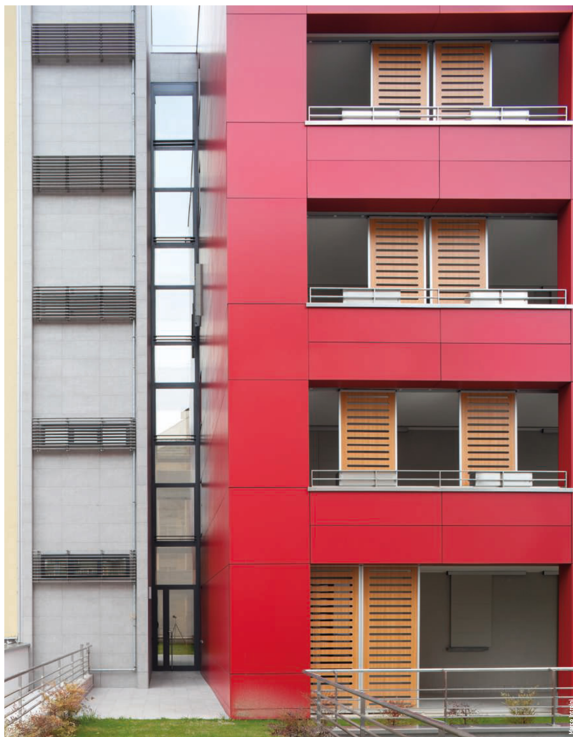
Un sistema di passerelle vetrate collegano il vano scala all'edificio residenziale A system of glazed walkways connect the staircase to the residential building
