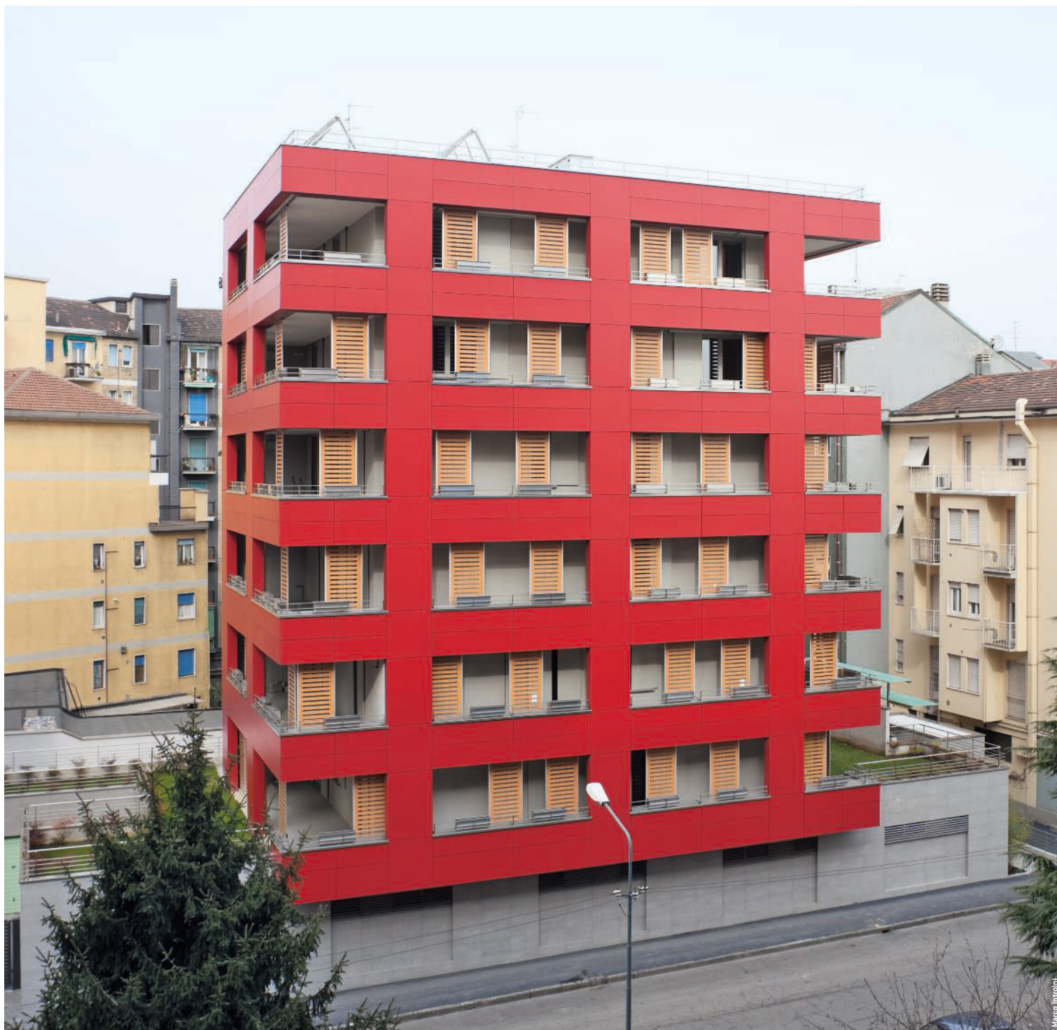
Il fronte sud-est South-east elevation
